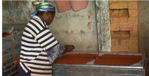
Façonnage des tuiles et moulage (prise du mortier) sur les supports
